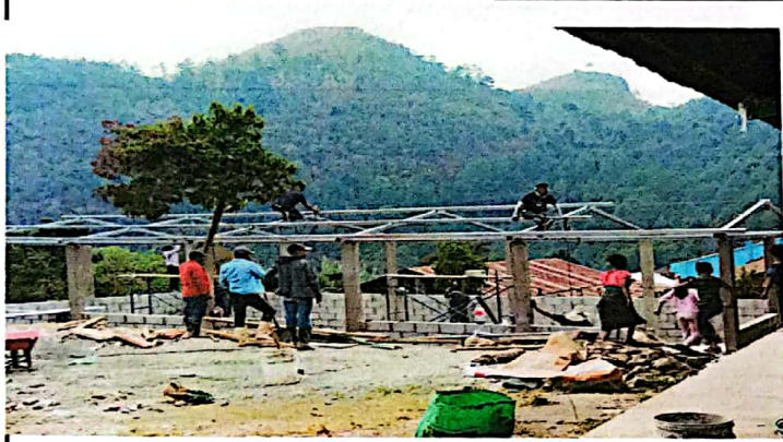
Foto 1: mejoramiento portico con cubierto de lamina
