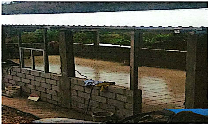
Foto 3: Mejoramiento de puertas y ventanas ya que no contamos con ellas en el centro educativo
